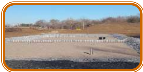
Démarrage construction nouvelle station
